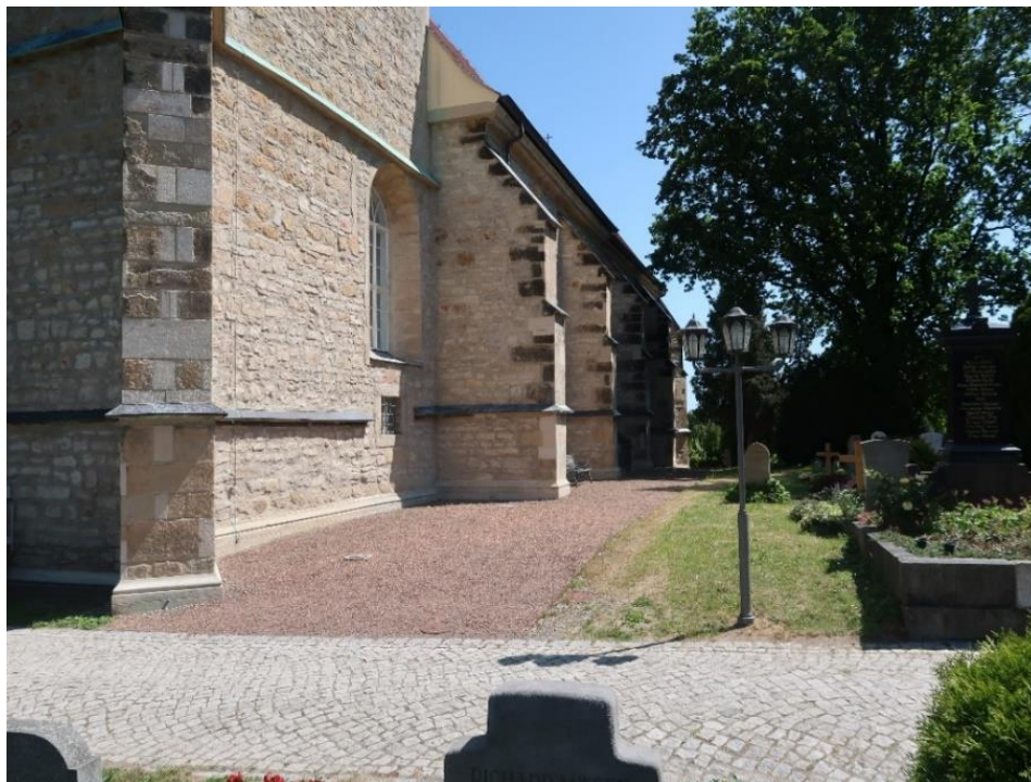
Obr. 13 Jižní strana s podzemním utěsněním půdy
