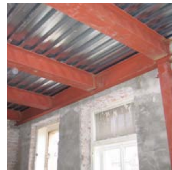
Vynesení stropu na předsazené sloupy (foto: Miroslav Herčík)
