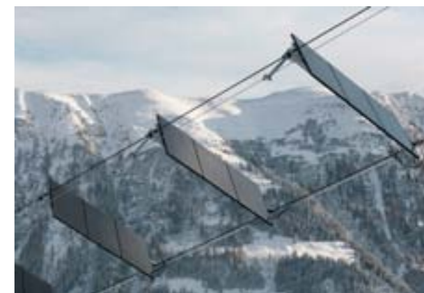
Detail natáčecích solárních křidel
