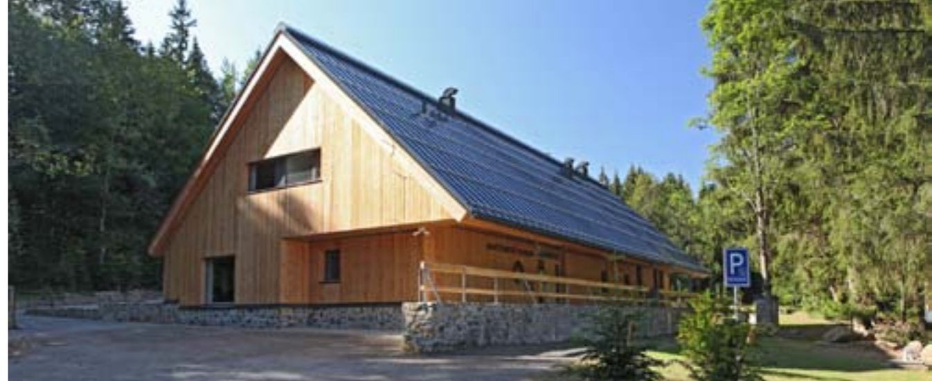
Celkový pohled na návštěvnické centrum v Srní od severu
