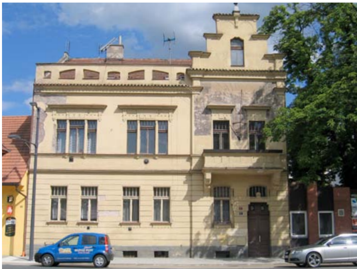
Stav před opravou
