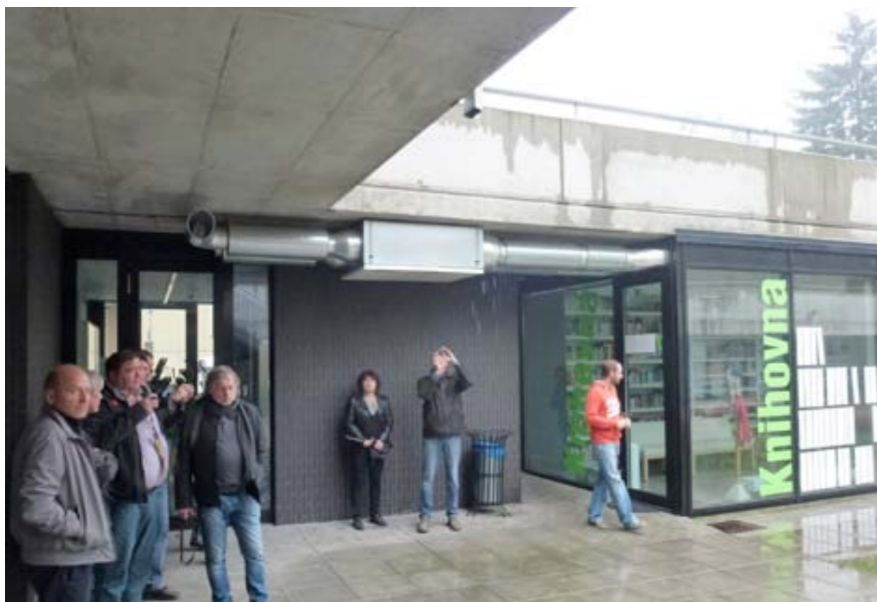
Případ pátý – nedomyšlené doplnění řízeného větrání v exteriéru novostavby polyfunkčního kulturního centra v podhorské oblasti na severu Čech
