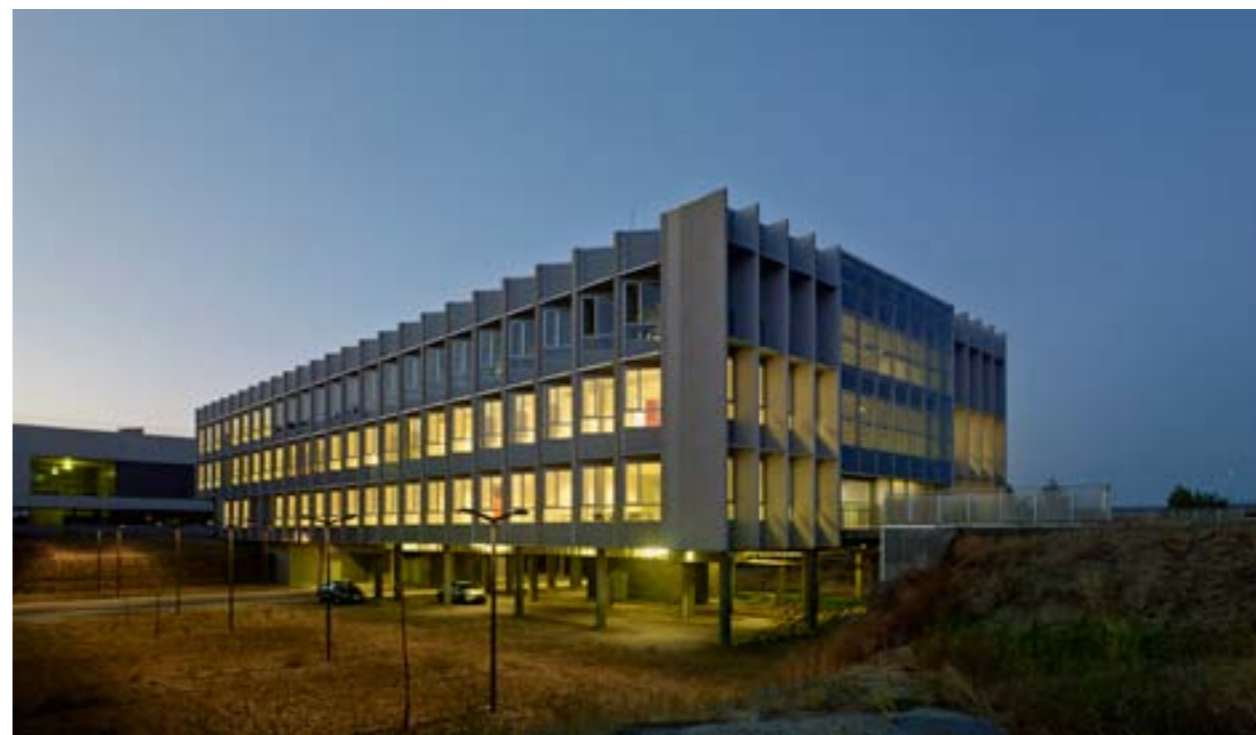
Budovy s nulovou spotřebou energie: budova Lucia, Univerzita ve Valladolidu, Španělsko
