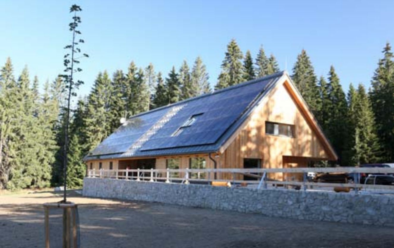
Celkový pohled na návštěvnické centrum na Kvildě od jihu
