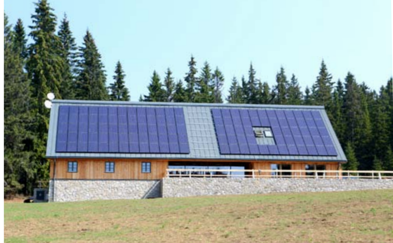
Na jižní fasádě návštěvnického centra na Kvildě je umístěno 121 fotovoltaických panelů
