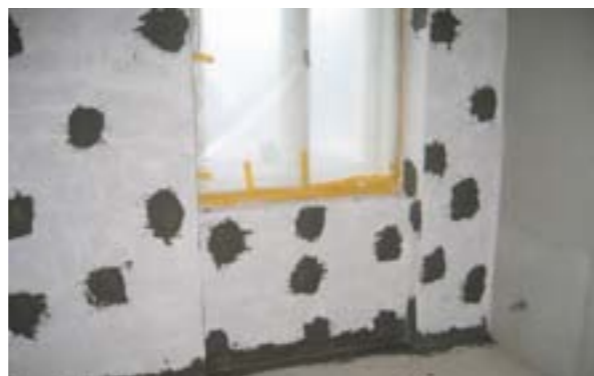
Vnitřní zateplení stěn (foto: Miroslav Herčík)
