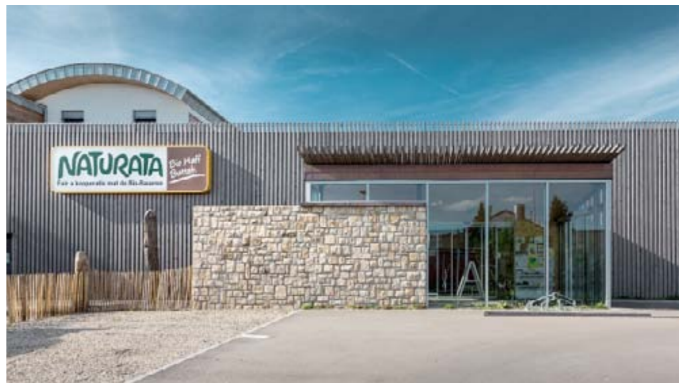
Stavba je z 90 % z přírodních materiálů – dřevo, kámen, celulóza
