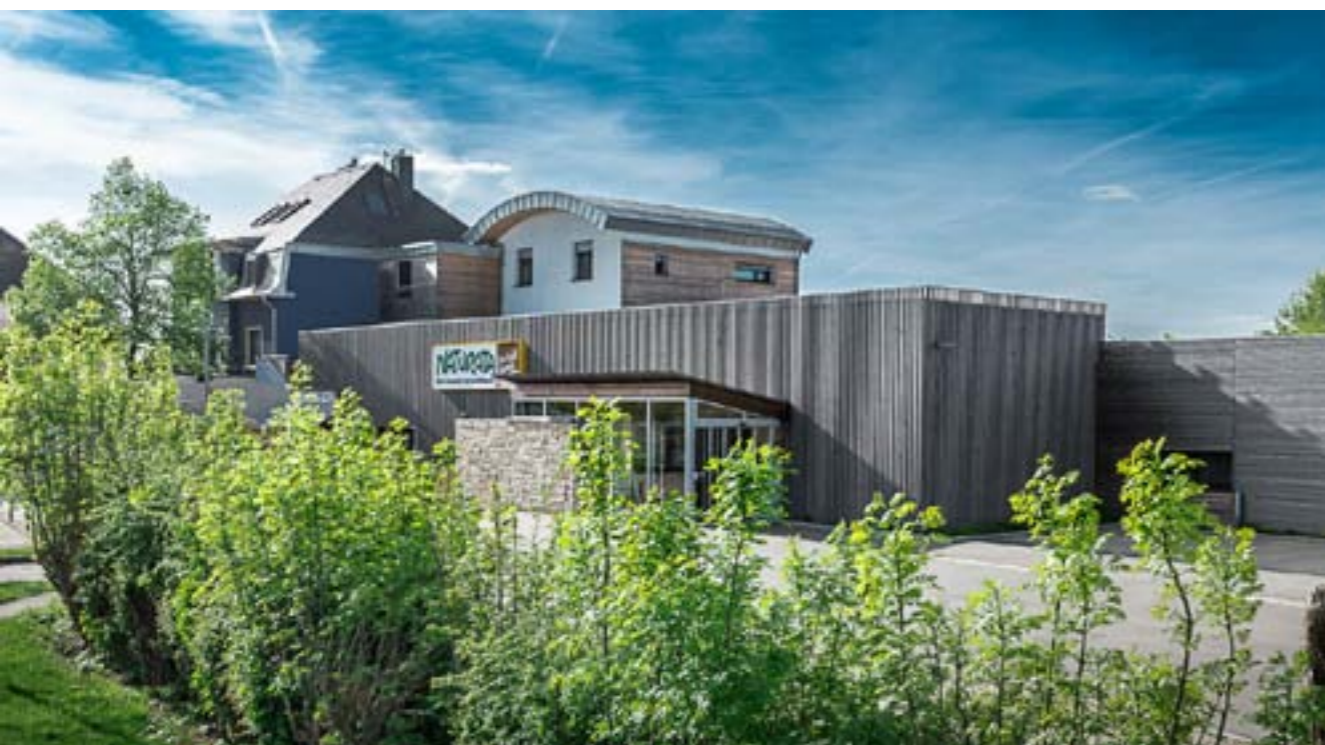
Na střeše supermarketu vznikl pasivní dům se zahradou
