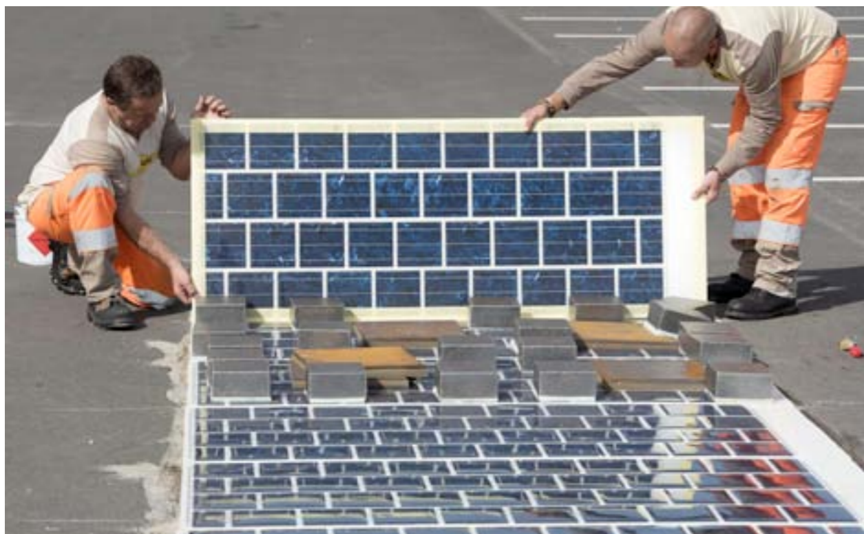
Pokládka zkušebního úseku silnice (foto: archiv firmy Colas)
