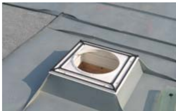
Světlovody zajišťují přirozené osvětlení podkrovního bytu (foto: Miroslav Herčík)
