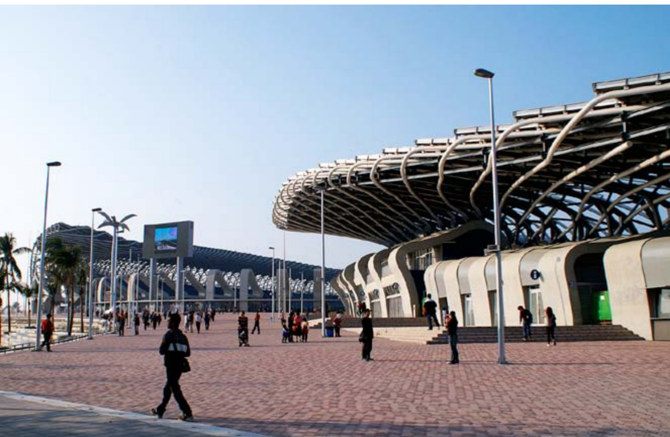
Materiály použité na výstavbu stadionu jsou stoprocentně recyklovatelné a pocházejí z Tchaj-wanu
