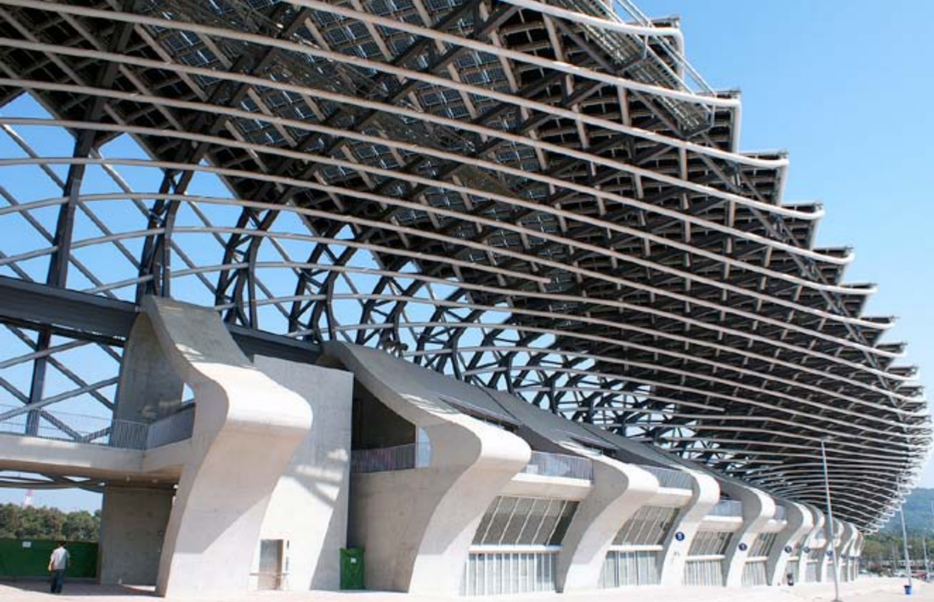
Robustní betonové nosníky zvedají do výše ocelovou konstrukci, na níž jsou připevněny solární panely
