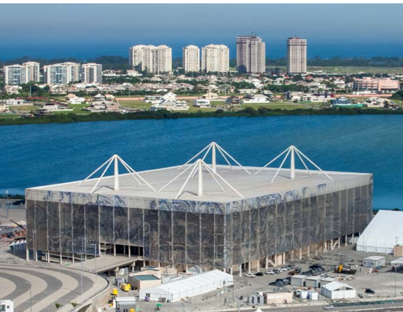
Přirozeného větrání bylo docíleno vyvrtáním 15 000 malých otvorů do konstrukce. (Foto: André Motta, Brasil2016.gov.br.)
