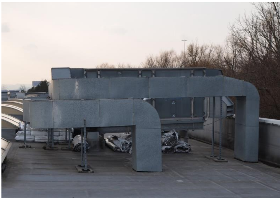
Obr. 15 Skladovaný materiál na střeše a lokální zatížení jednotlivých vln
