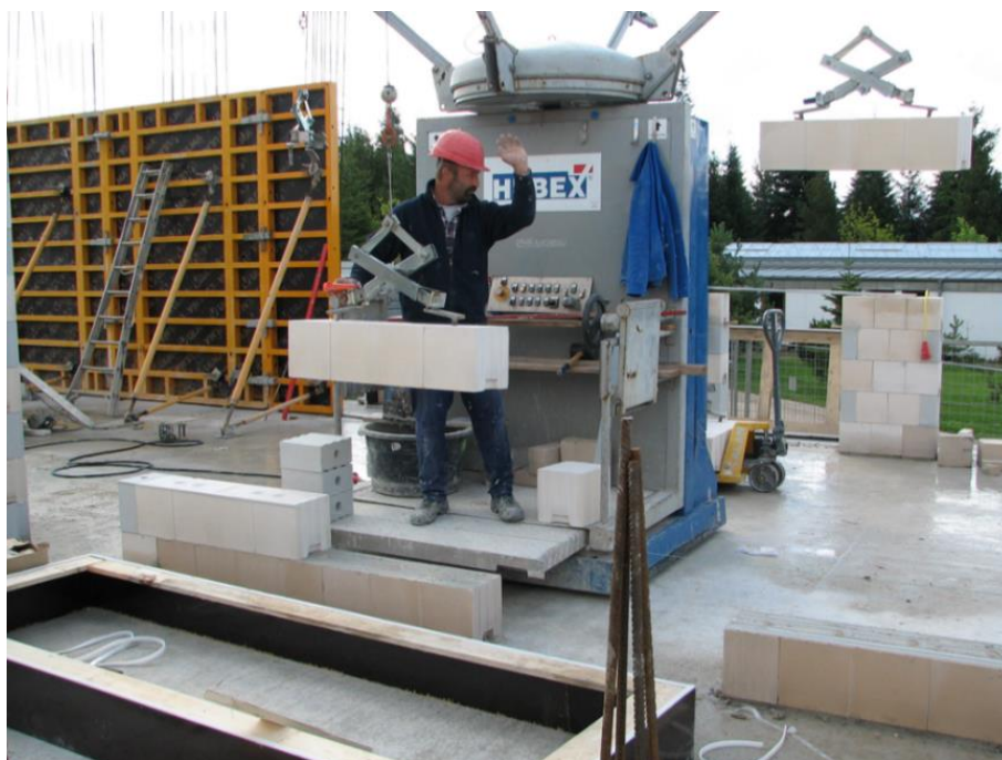
Obr. 9 Univerzální zdicí stroj
