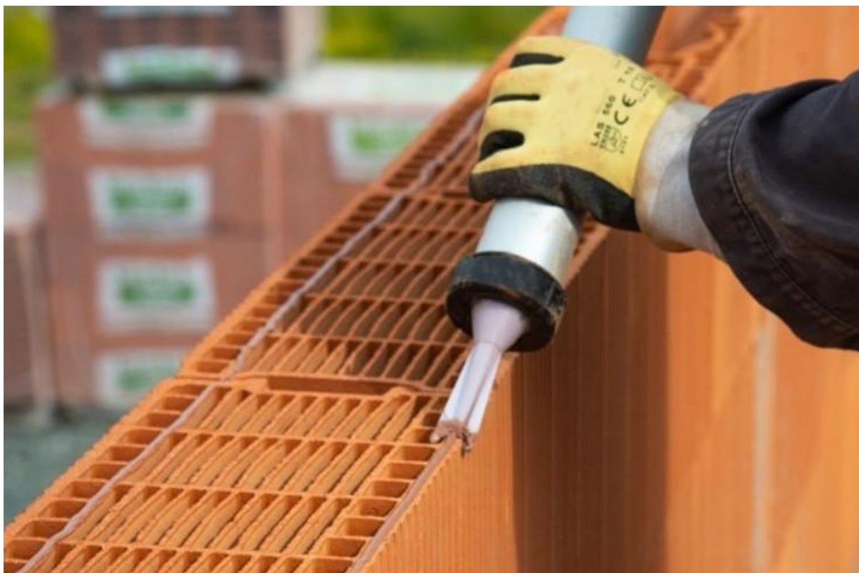
Obr. 2 Ukázka technologie zdění broušených cihel – systém Biobric Fix'bric [3]
