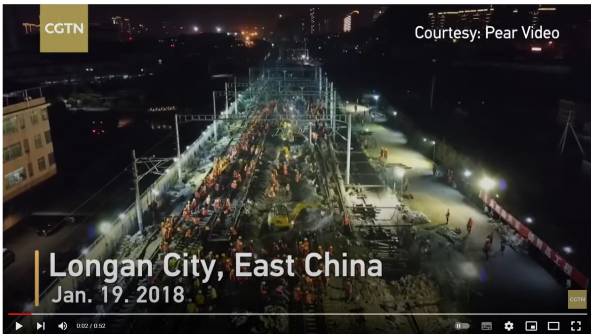
Obr. 2 Rychlost stavebních prací v Číně, zdroj: https://youtu.be/TDgVm_Ffe1s?si=TRIVnwILKGIBXupm
