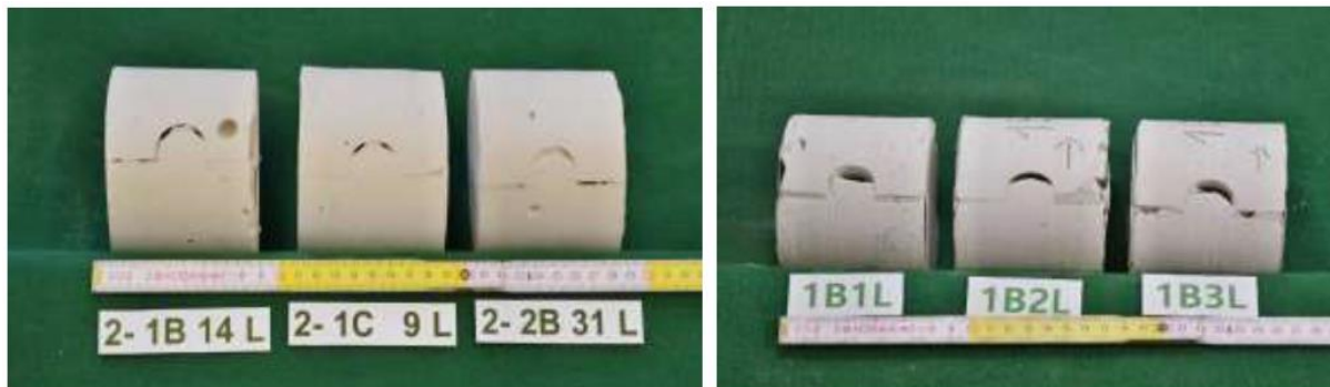
Obr. 4 Příklad vyplnění ložných spár – a) téměř úplné vyplnění spáry (vlevo), b) částečné vyplnění spáry (vpravo)
