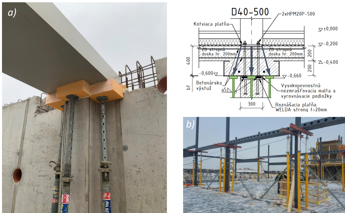
Obr. 5a Vytvorenie debnenia zálievky DELTABEAM ® nosníka, 5b podopretie nosníka pri podpere.
