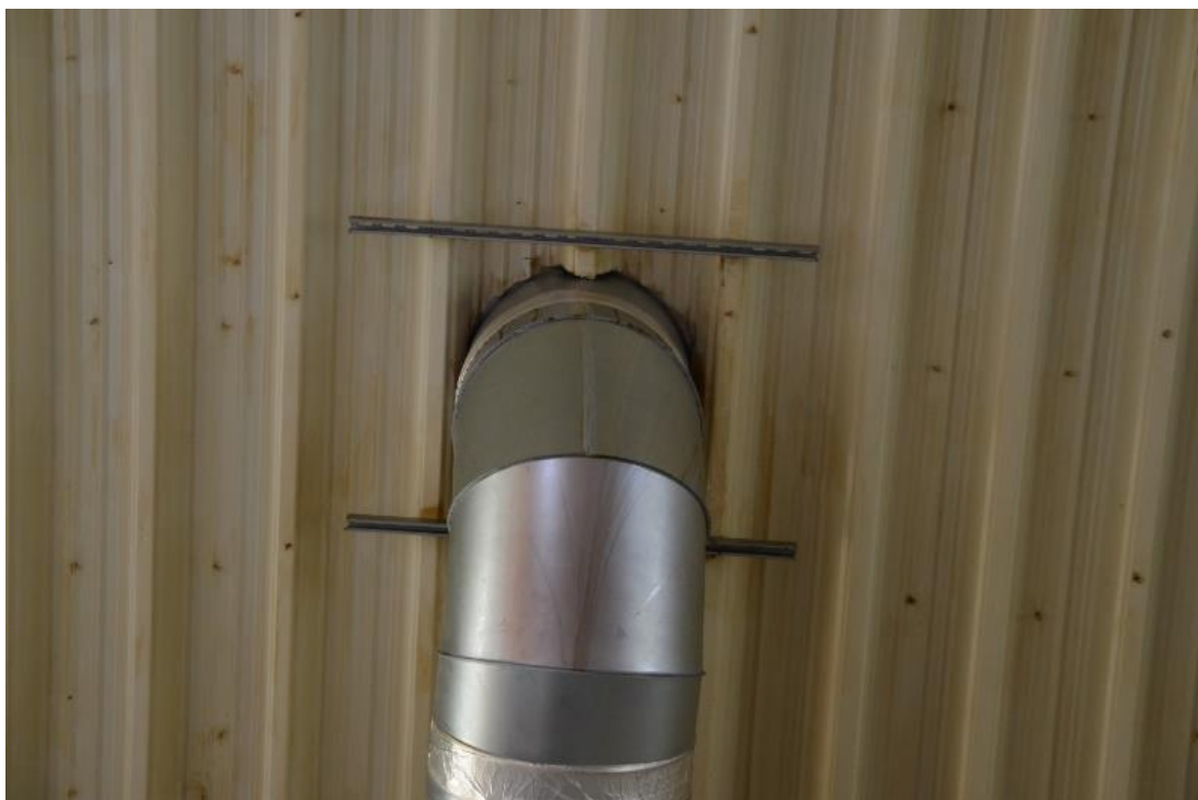
Obr. 9 Prostup trapézovým plechem zajištěný výměnou do ostatních vln – sousední vlny jsou výrazně více namáhány, roznášecí prvek má diskutabilní nosnost i tuhost
