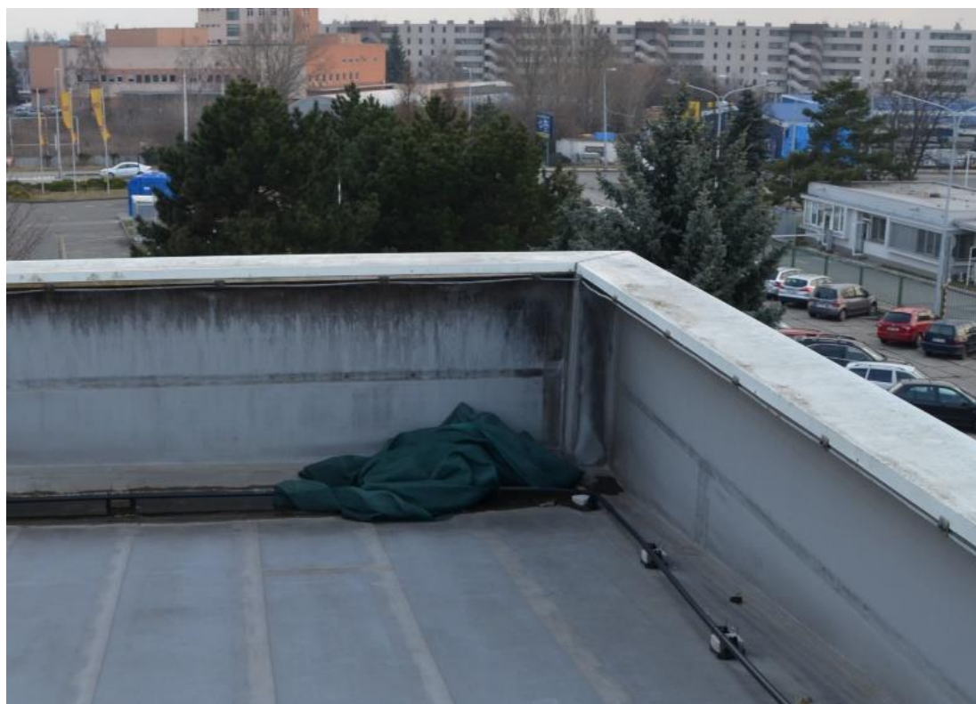
Obr. 14 Ucpané odtoky vody
