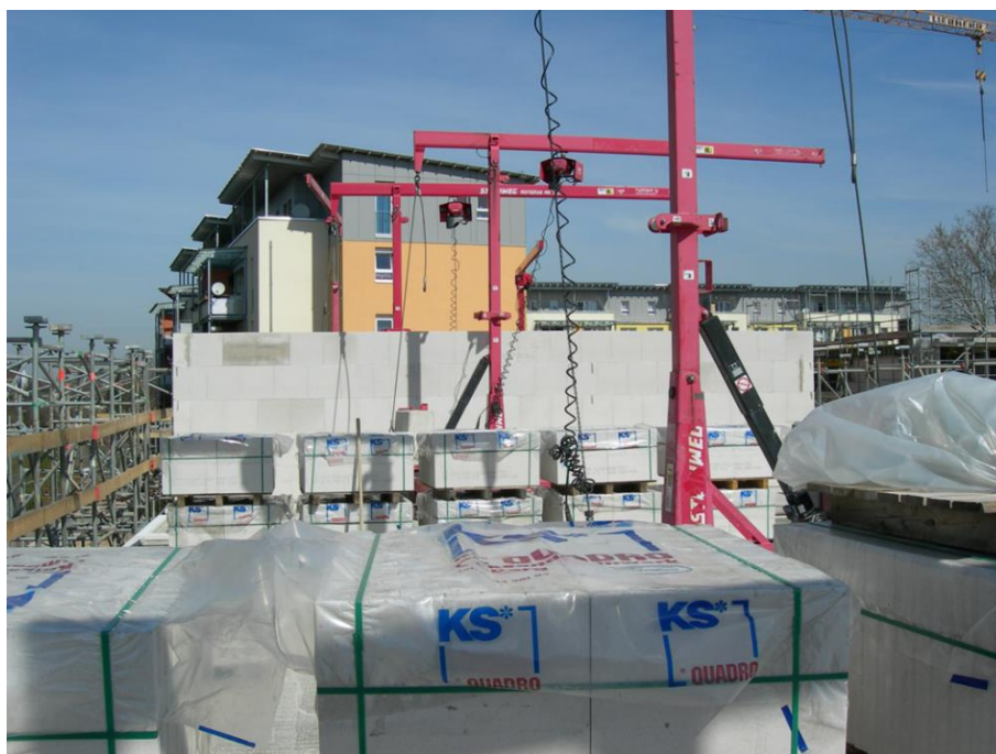
Obr. 10 Nasazení minijeřábů MK300
