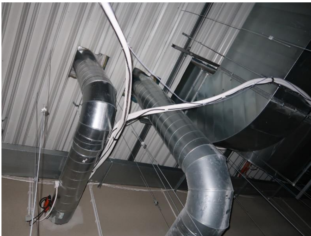
Obr. 11 Nezajištěný vstup trapézovým plechem – přerušená vlna trapézového plechu
