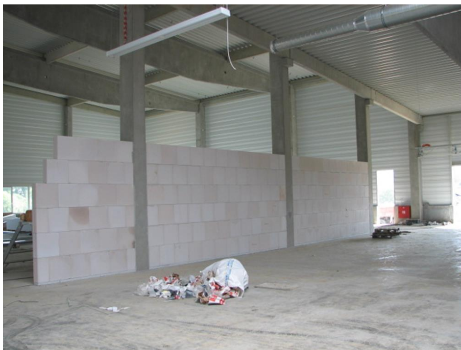
Obr. 5 První strojní zdění, protipožární zeď hala Domažlice, r. 2007
