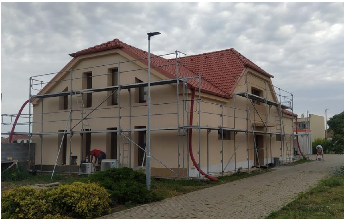
Obr. 24 Administrativní budova městyse – dokončovací práce
