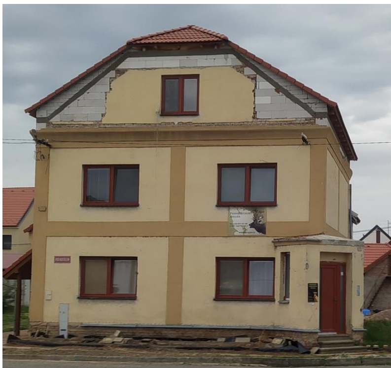
Obr. 25 Rozšíření podkroví RD
