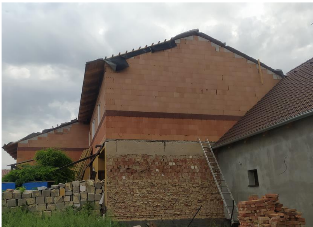
Obr. 33 Objekt RD po rekonstrukci – nová nástavba
