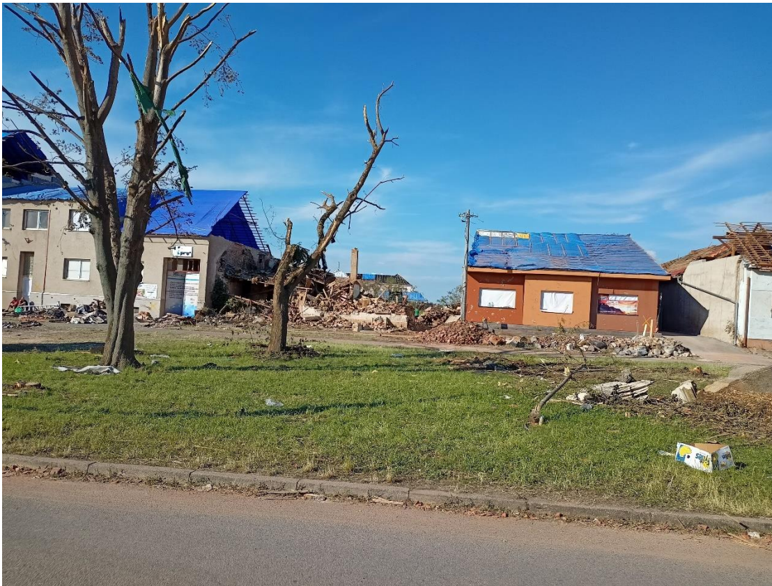
Obr. 11 Škody způsobené tornádem – úplná destrukce objektu
