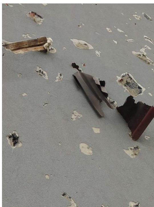
Obr. 7 Škody způsobené unášenými předměty
