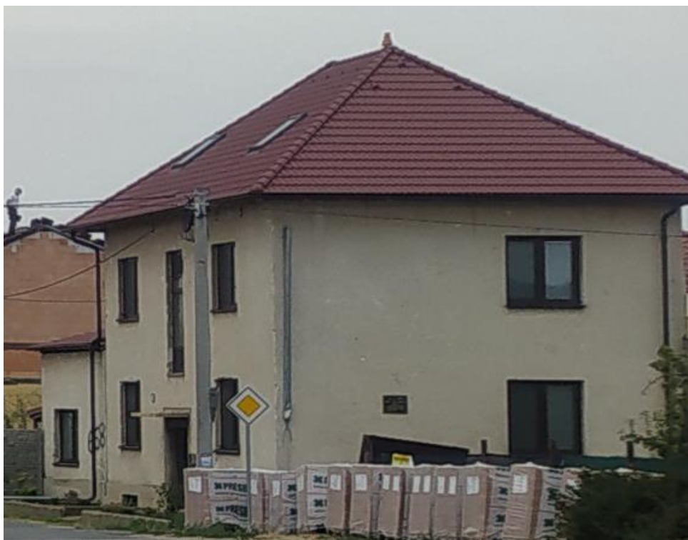
Obr. 27 Stav RD v srpnu 2022
