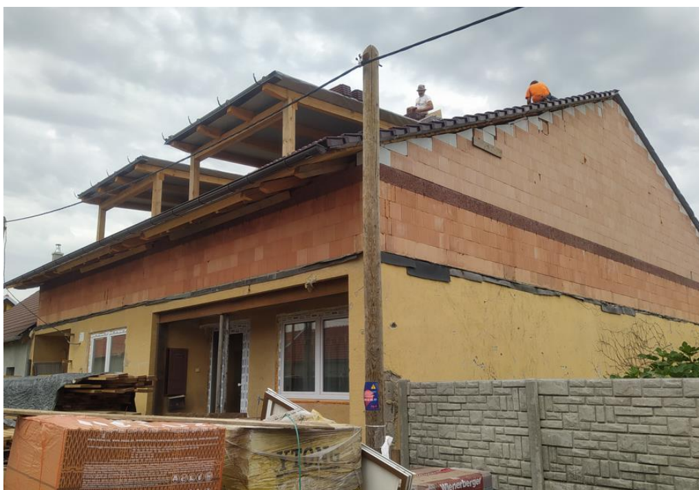
Obr. 34 Objekt RD po rekonstrukci – nová nástavba (pohled z ulice)
