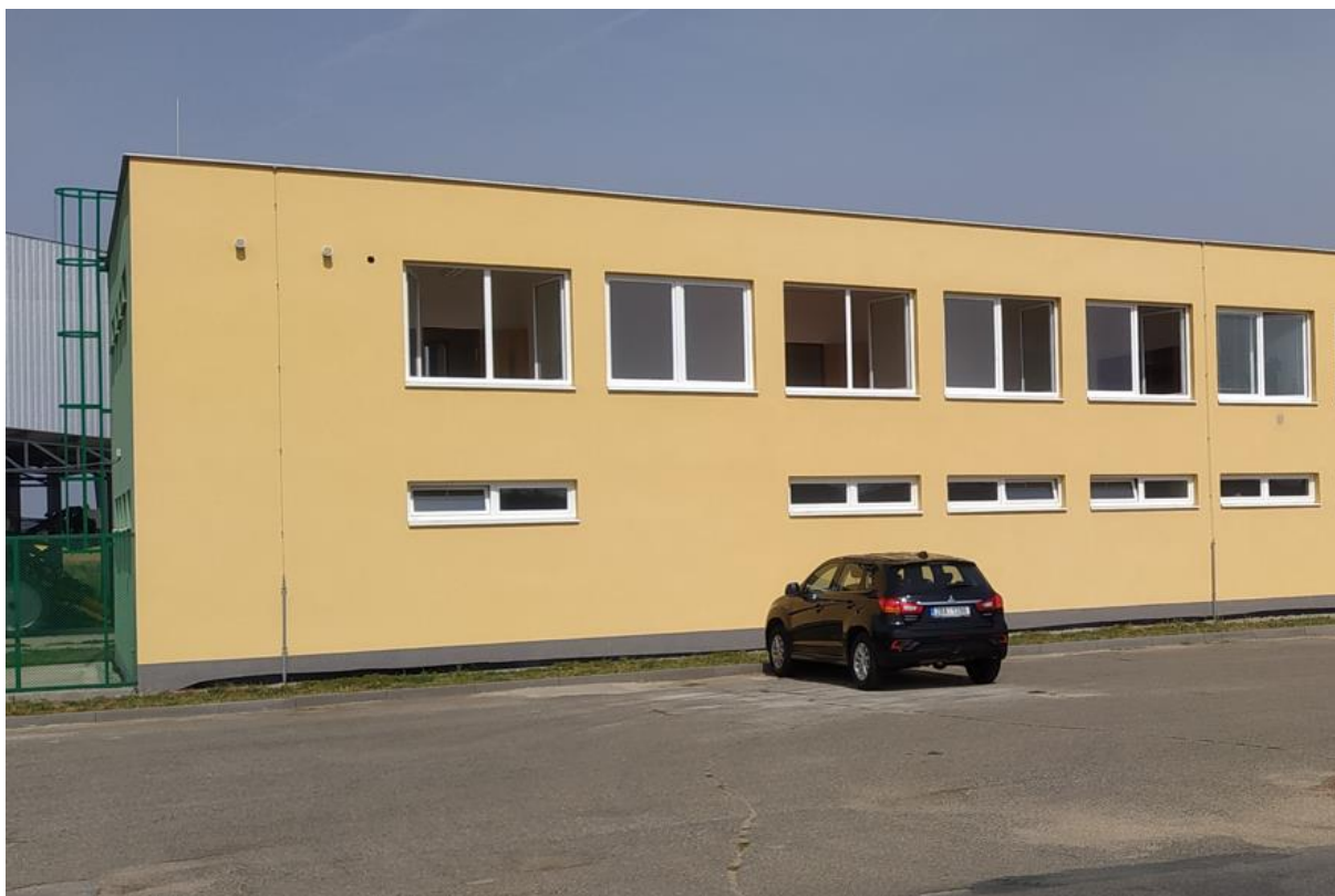
Obr. 22 Administrativní budova zemědělského podniku po opravě
