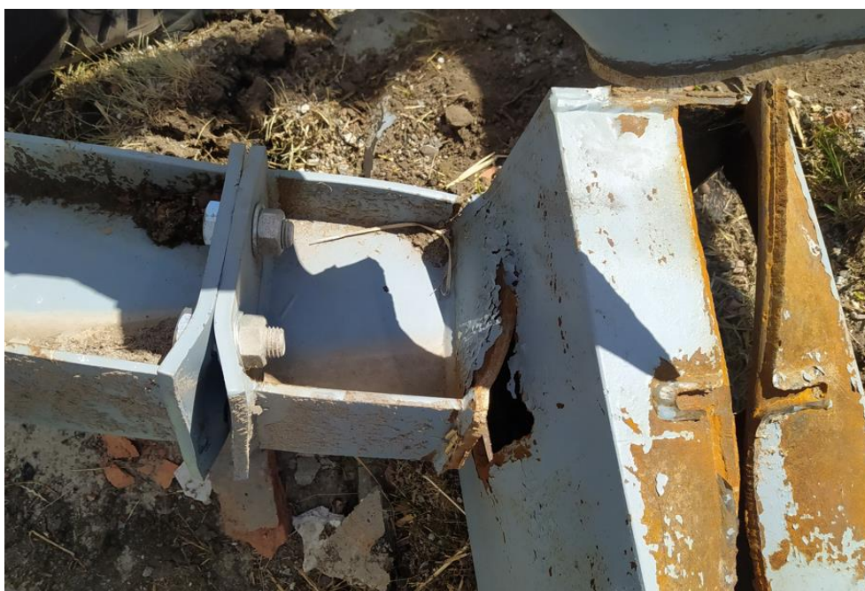
Obr. 38 Vytržení prvků svařovaného styčnicku
